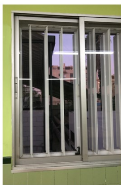
Ventanas totalmente cerradas.
